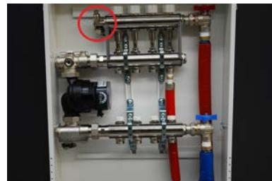
7. Füllen der Anlage: alle Vorlauf/Rücklauf-Ventile des Primärkreises (rot und blau) schließen; manuelle Öffnung des ersten Thermostat-Ventileinsatzes durch Drehen des entsprechenden Drehknopfs gegen den Uhrzeigersinn
