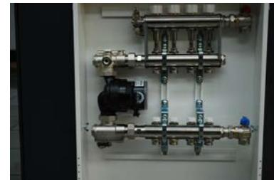
4. Verbindung der Primärkreise Vorlauf/Rücklauf vom Wärmeerzeuger
