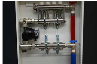
5. Anschluss und Absperrung des Vorlauf/Rücklauf -Sekundärkreises vom Nieder- und Hochtemperatursystem
