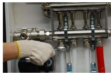
6. Hydraulikanschluss zum Befüllen der Anlage
