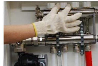
9. Füllen der Anlage: Öffnung des ersten Rücklaufverschraubung durch Drehen des Inbusschlüssels gegen den Uhrzeigersinn
