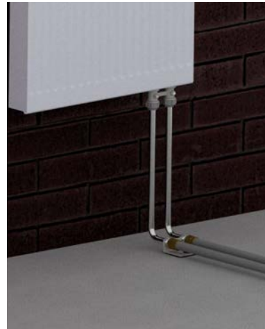
Detail des fertigen Anschlusses (vor der Bodenverlegung).
