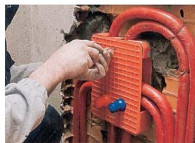
Si procede quindi al rabbocco delle tracce; una parte importante dell'installazione è ultimata. Verrà successivamente realizzato il sottofondo necessario per la posa delle piastrelle.
