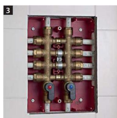
Esempio: collettore 4x4 installato ed esecuzione finita. E' possibile l'ispezione del collettore e l'azionamento dei rubinetti, dopo la semplice rimozione dello sportello.
