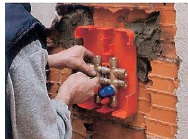
Si inizia il collegamento del tubo al collettore, prestando attenzione nella calibratura dell'estremità. Si inseriscono nel tubo gli elementi della tenuta: dado, ogiva ed inserto.
