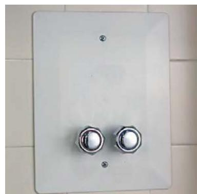
3) Sistema con ispezione del collettore e dei rubinetti: è il sistema più tradizionale, sempre usato negli impianti a collettore; i due rubinetti, incorporati nel collettore, sono azionabili solo dopo l'apertura dello sportello.
