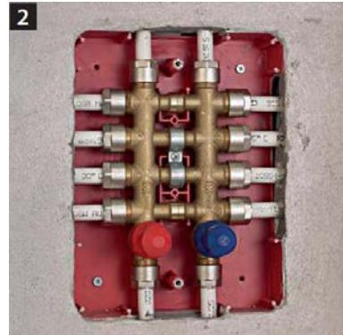
Esempio: collettore 4x4 installato ed esecuzione finita. È possibile l'ispezione del collettore e l'azionamento dei rubinetti, dopo la semplice rimozione dello sportello.
