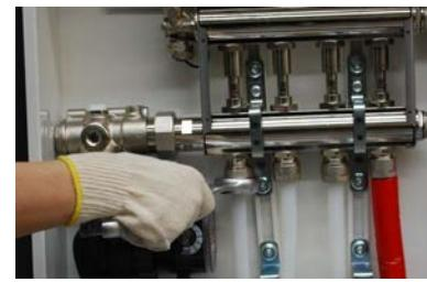
6. Collegamento idraulico da cui effettuare il riempimento dell'impianto
