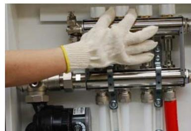
9. Riempimento impianto: apertura del primo detentore ruotando la chiave a brugola in senso antiorario
