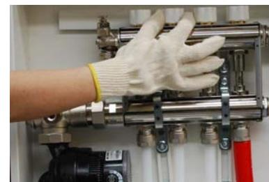
9. Remplissage du système : ouvrir le premier clapet anti-retour en tournant la clé Allen dans le sens inverse des aiguilles d'une montre
