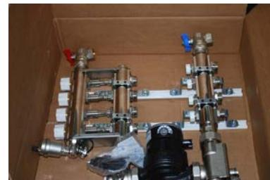
3. Installez l'unité de commande dans la boîte, en la fixant d'abord sur les supports en haut, puis sur ceux situés en bas
