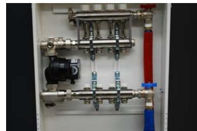
5. Raccordement et serrage du circuit secondaire d'alimentation/de retour du système à basse et haute température
