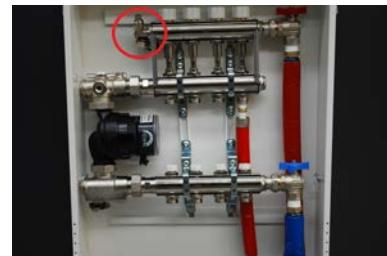
7. Remplissage du système : fermer les vannes d'approvisionnement/de retour du circuit primaire (rouge et bleu) ; ouvrir manuellement le premier obturateur thermostatique et tourner le bouton dans le sens inverse des aiguilles d'une montre
