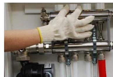
9. Llenado de la instalación: apertura del primer detentor rotando la llave hexagonal en sentido antihorario
