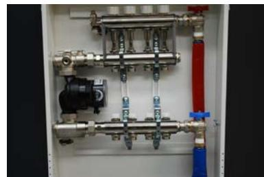
5. Conexión y ajuste de los circuitos secundarios ida/vuelta del sistema en baja y alta temperatura
