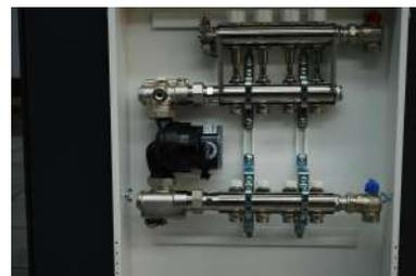
4. Verbindung der Primärkreise Vorlauf/Rücklauf vom Wärmerezeuger
