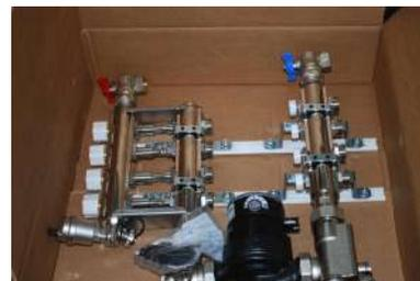
3. Die Mischeinheit im entsprechenden Verteilerkasten installieren, indem sie zuerst an den oberen, dann an den unteren Halterungen eingehängt wird
