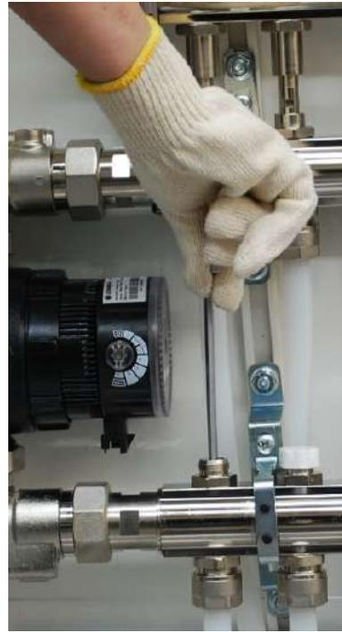
10. Füllen der Anlage: Schließung sämtlicher nachfolgenden Regulierventile durch Drehen des Inbusschlüssels in Uhrzeigerichtung
