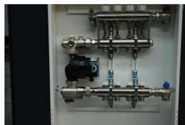
4. Подключение подающего/обратного контура от теплогенератора.
