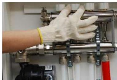
9. Заполнение системы: открытие первого клапана поворотом шестигранного ключа против часовой стрелки.
