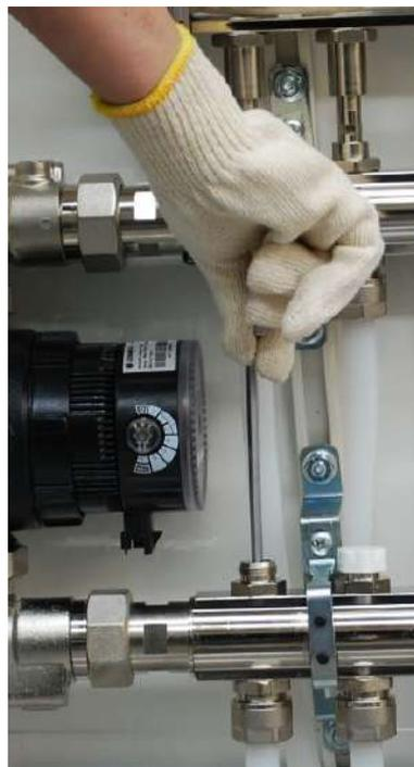
10. Llenado de la instalación: cerrado de los detentores sucesivos girando la llave exagonal en sentido horario
