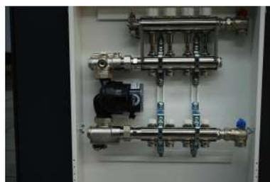
4. Conexión de los circuitos primarios ida/vuelta del generador de calor
