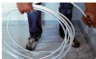
Zum Verlegen des Rohrs beginnt man am Vorlaufverteiler mit einem Doppelspiralschema, sofern keine anderen Projektanleitungen vorliegen.
