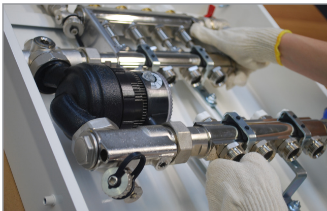
3. Installare la centralina nell'apposita cassetta, agganciandola prima sulle staffe in alto e successivamente su quelle in basso
