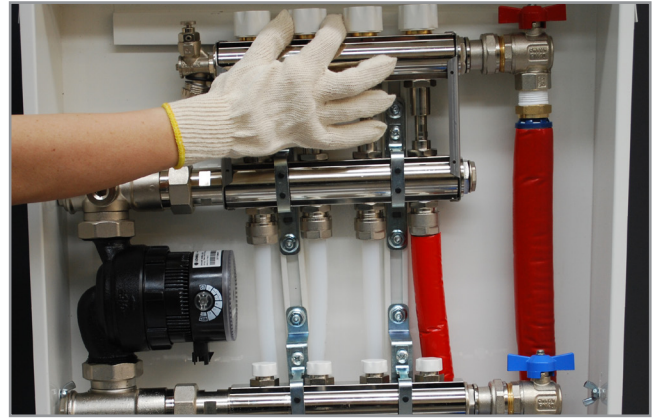
7. Riempimento impianto: chiusura degli otturatori successivi ruotando in senso orario le apposite manopole
