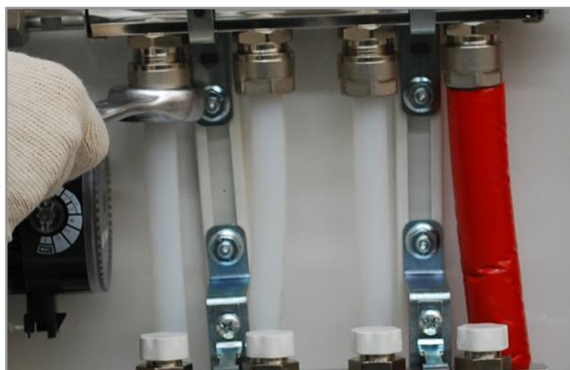
5. Collegamento e serraggio del secondario andata/ritorno dal sistema in bassa temperatura e alta temperatura
