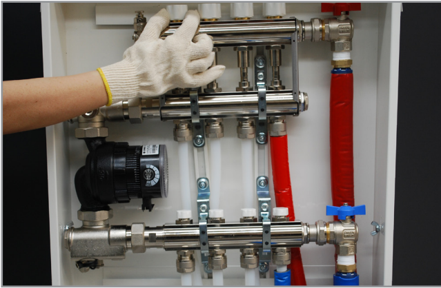
6. Riempimento impianto: chiudere le valvole di andata/ritorno del circuito primario (rossa e blu); apertura manuale del primo otturatore termostatico e ruotando in senso antiorario l'apposita manopola
