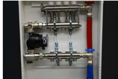
5. Collegamento e serraggio del secondario andata/ritorno dal sistema in bassa temperatura e alta temperatura
