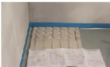
Posez la feuille de polyéthylène de la bande sur la plaque isolante et posez le tube en polyéthylène par-dessus afin d'éviter une éventuelle infiltration de la chape.
