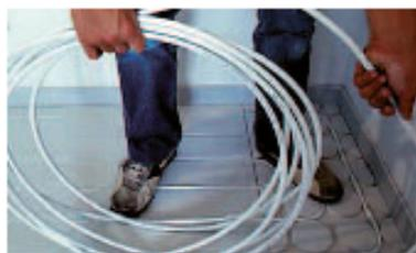
Au point de sortie du sol, les tubes doivent être protégés par des coudes de fixation.
