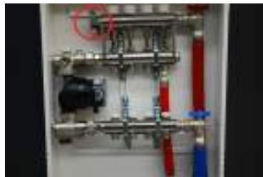
7. Заполнение системы: закрытие подающих/ обратных клапанов первичного контура (красный и синий); ручное открытие первого термостатического затвора и поворачивая соответствующую ручку против часовой стрелки.
