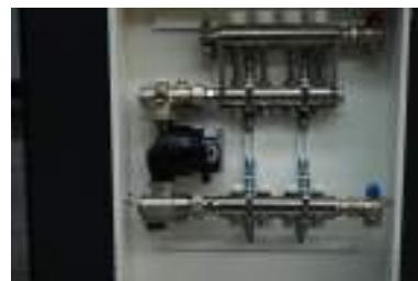
4. Подключение подающего/обратного контура от теплогенератора.
