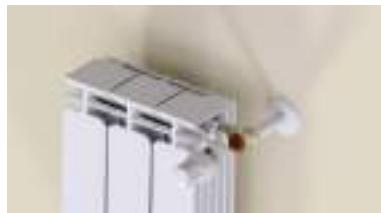
Прикрутите терmostатическую головку к клапану и установите селекторный переключатель в нужное положение.
