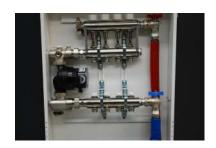
5. Подключение и затяжка подающих и обратных вторичных контуров от высокотемпературных и низкотемпературных систем.
