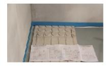
Die Polyethylenfolie auf die Isolierplatte legen , dann das Polyethylenrohr so darauf verlegen, dass kein Estrich durchsickern kann.
