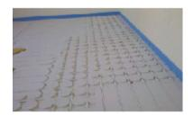
REALISIERUNG DER KREISLÄUFE Sobald die Platten am Boden befestigt wurden, kann mit der Verlegung der Rohrleitung begonnen werden, indem das Rohr in die Fugen an den Platten gesetzt wird. Zum Verlegen des Rohrs beginnt man am Vorlaufverteiler mit einem Doppelspiralschema, sofern keine anderen Projektanleitungen vorliegen.
