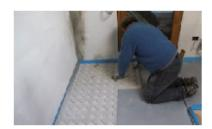
Die Dämmplatten dicht am Randdämmstreifen verlegen.
